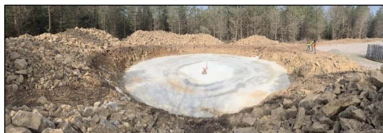
Construction d'une fondation
