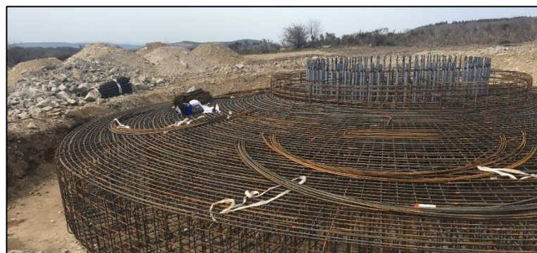
Construction d'une fondation
